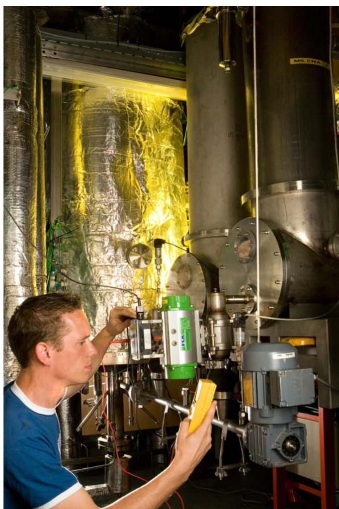
Testinstallatie voor de MILENA vergassingstechnologie bij ECN
